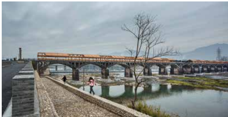
DnA Architects: Shimen híd újraháznosítása (Kína, Lishui, 2017)
