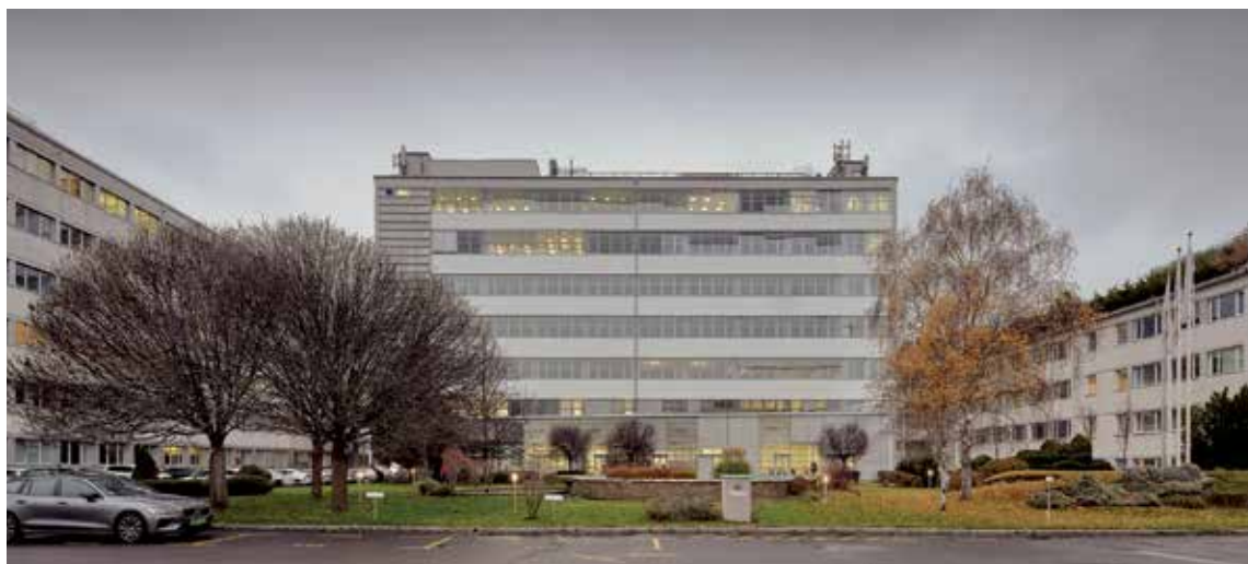
3. kép: A Gizella Loft az utóbbi évek egyik legjobban sikerült értéktisztelő épület-újrahaznosítása, ahol a tervezési döntéseket részletes életciklus-elemzés segítette (a felújítás tervezője: LABS architects, fejlesztő: Gladiátor III / Wing Zrt., Fotó: Batár Zsolt) Forrás © LABS Építésziroda
