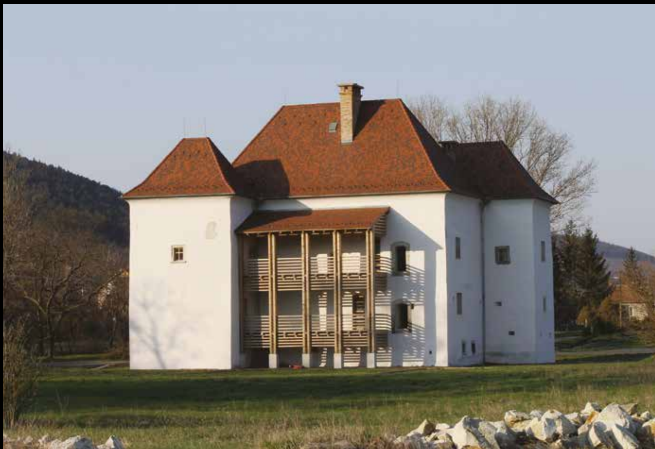
Régi Vay-kastély felújítása, Golop – fotó: Szász István
