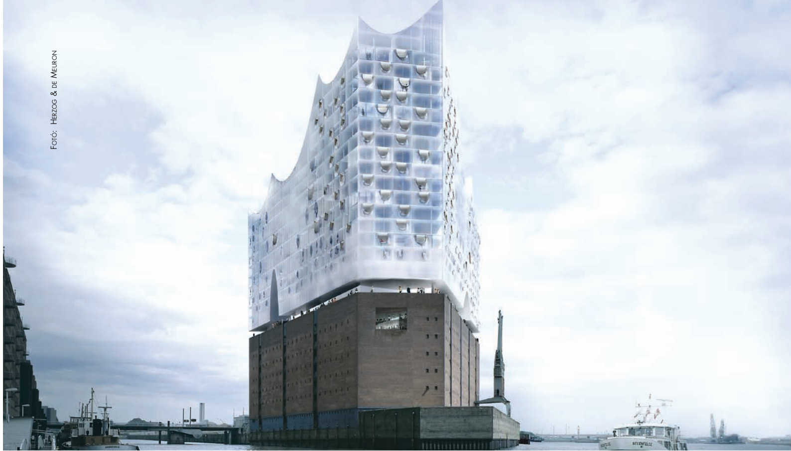
Az épülő Elbphilharmonie épülete
