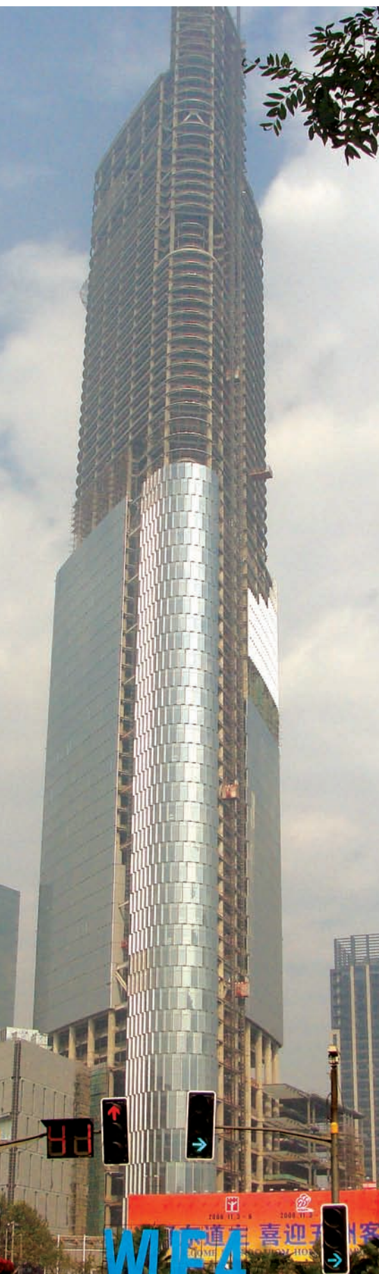
Épülő felhőkarcoló a városközpontban – Gulou tér
