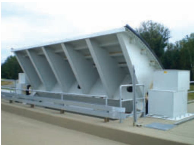
Tiszakarádi árapasztó tározó – Cigánd
