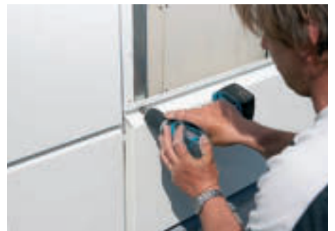
4. ábra: A falkazetták szerelése gyors és egyszerű
