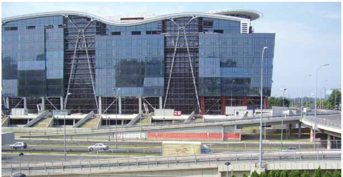
Épülő irodaház Belgrádban
