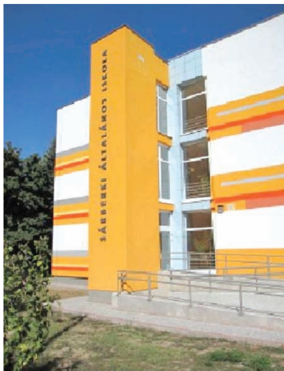
Tatabánya, Sárberki Általános Iskola felújítása
