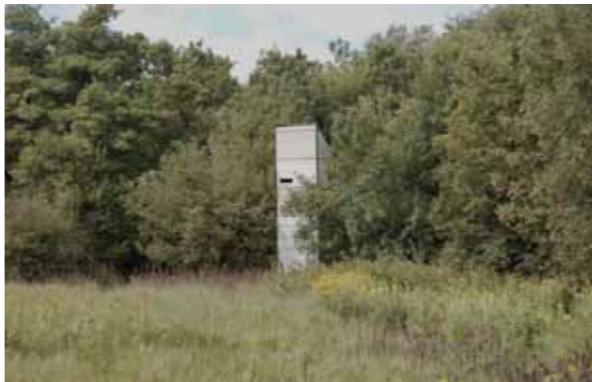
Denevértornyok (Kiskunsági Nemzeti Park). Építész: Vinczellér Zsolt
