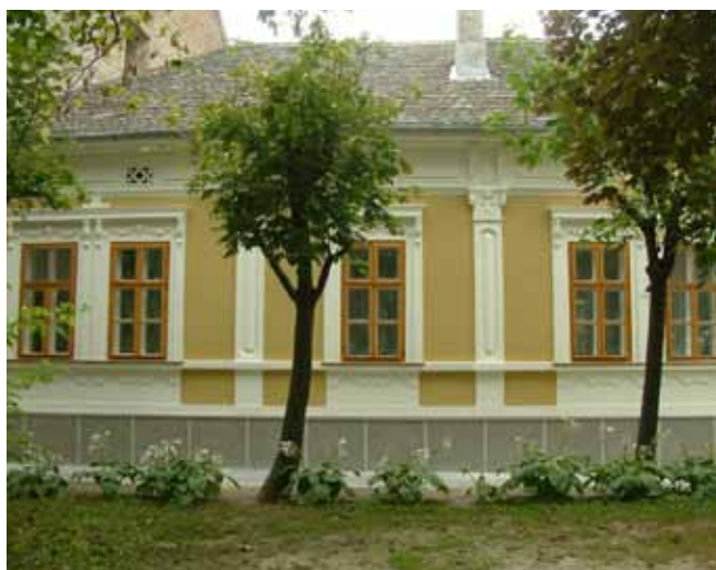
Makó, Szent István tér 18. lakóépület homlokzat felújítása – a „Helyi Építészeti Örökség” építészeti nivódj nyertese 2010-ben ( http://epiteszforum.hu/galeria/mako-szent-istvan-ter-18-lakoepulet-homlokzat-felujitasa/72030 )
