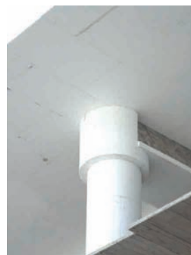
Oszlop hőszigetelés
