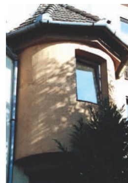
Íves fal sokszögletű hőszigetelése
