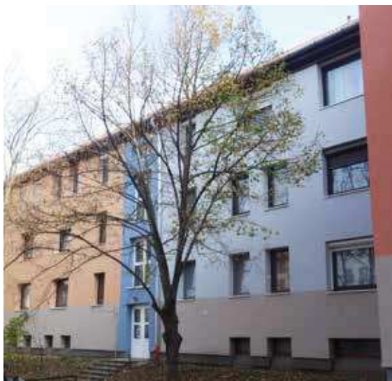
Panelszínezési program épülete Káposztásmegyér, színtervező: Tari Gábor
