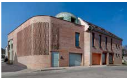
› Év háza 2019 – Családi ház, lakóépület kategória fődíj: Karlovecz Zoltán, háromlakásos lakóház üzlettel, Pécs
