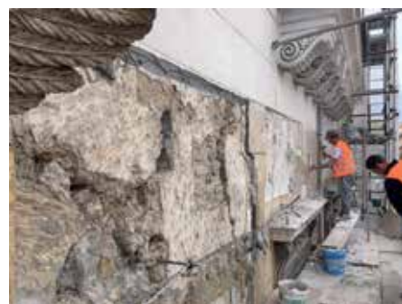
A leváló falazati és vakolati részek eltávolítása, valamint az aljzat tisztítása után a homlokzat SILANCOLOR BASE COAT-tal és SILANCOLOR PITTURA PLUS-szal lett lefestve és megvédve.
