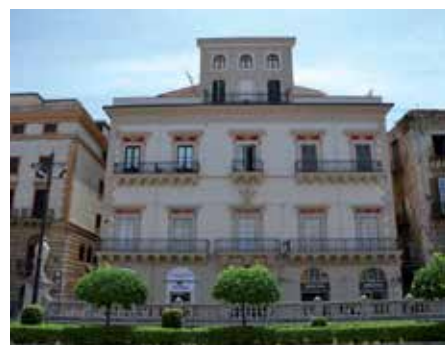
A palota a felújítási munkák után.
