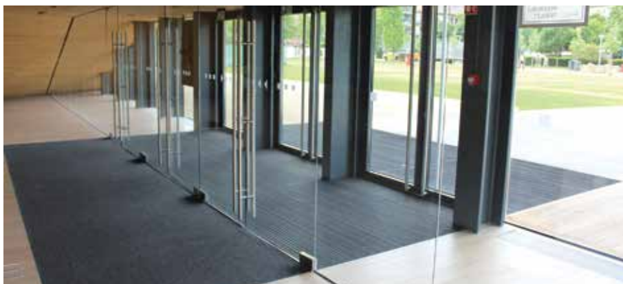
A hármas zóna szemlélet alapján tervezett és beépített, megfelelő méretű és tulajdonságú szennyfogó szőnyegek.
