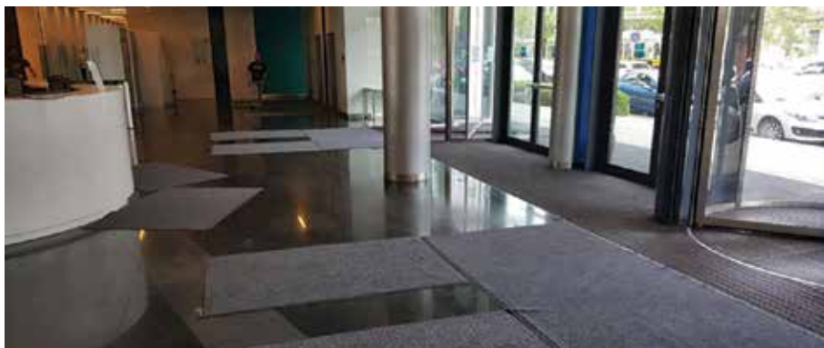
Méretben alultervezett beépített szennyfogó szőnyegek. Mögötte bérszőnyegdesign, ahogy az építész biztosan nem szeretné.
