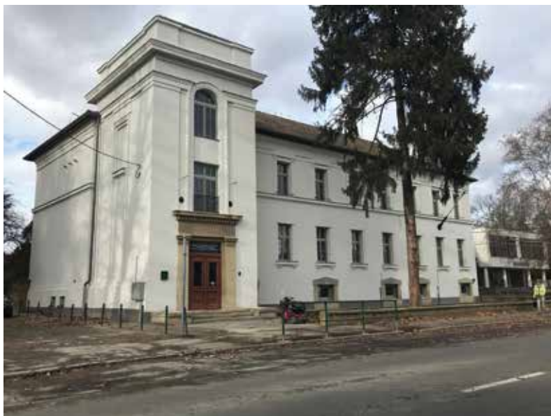
A bonyhádi zeneiskola a felújítás után
