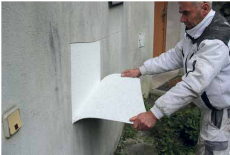
A vakolatréteg visszabontása
