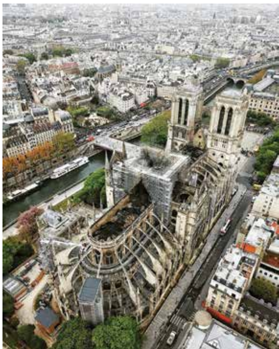
6. sz. kép. A párizsi Notre Dame felülnézeti képe a tüzesetet követően. A kép bal oldalán, a Szajna mellett látható a sekrestye tetőszerkezete (forrás: Lana Sator).
