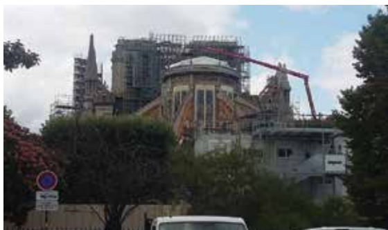
7. sz. kép. Védőtető- és fóliaépítés, a támvégek és a mérnöves ablakok stabilizálása 2019. július végén (fotó: Gécs Attila).
