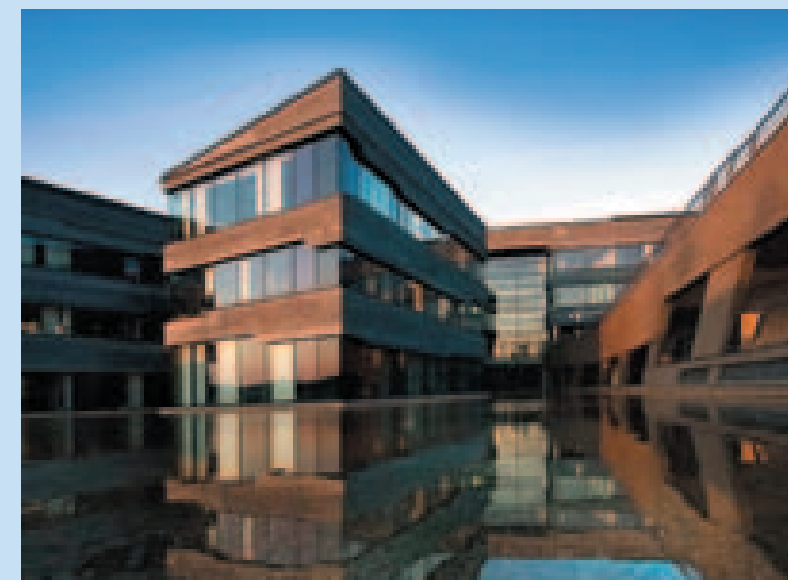
Central Premises of Telenor Távközlési Zrt.
