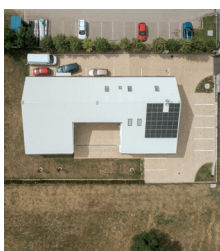
Irodaház és kereskedelmi épület Sopron, Faller Jenő u.
